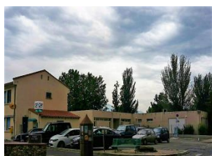
Borne recharge véhicules électriques
