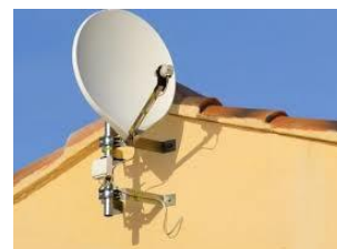
Pose d'antenne, parabole et vidéo
